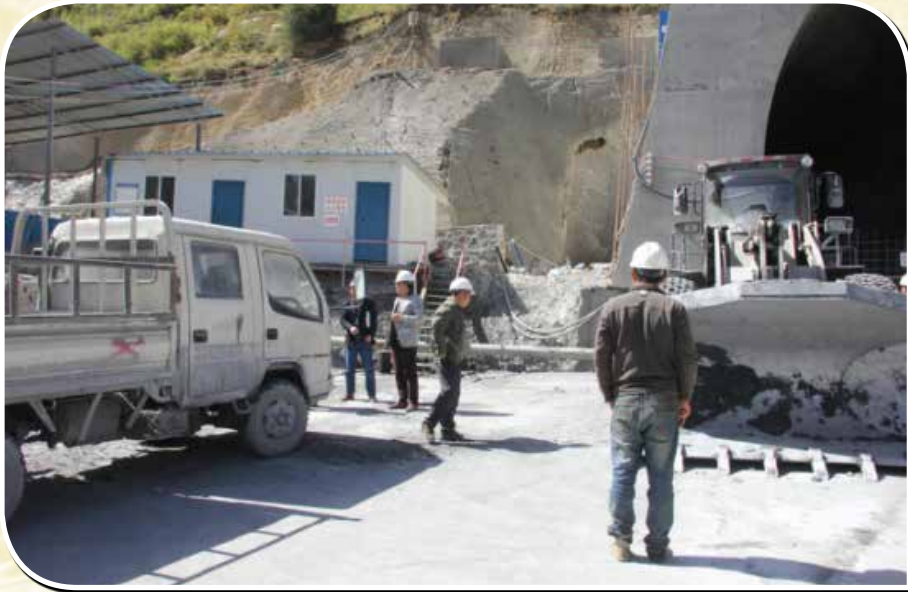
成兰铁路正在施工
