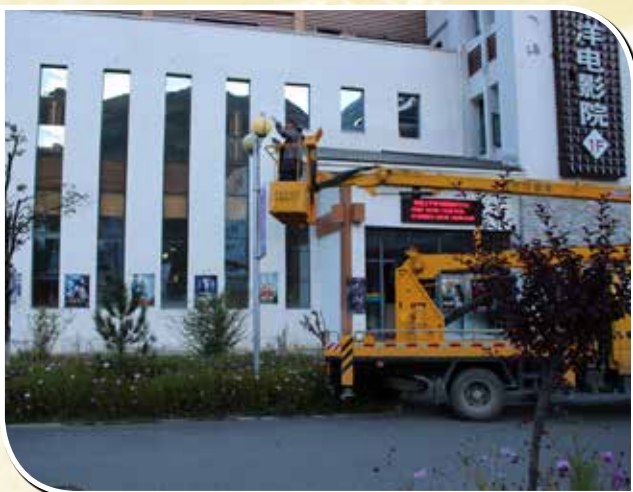
市政路灯维修
